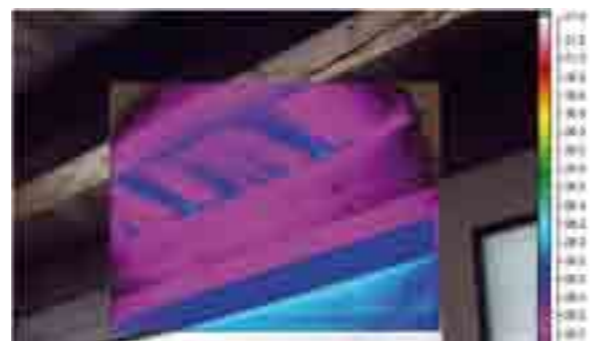
LA TERMOGRAFIA PERMETTE DI VERIFICARE LA QUALITÀ DEGLI INTERVENTI (FOTO: SAIGE)
